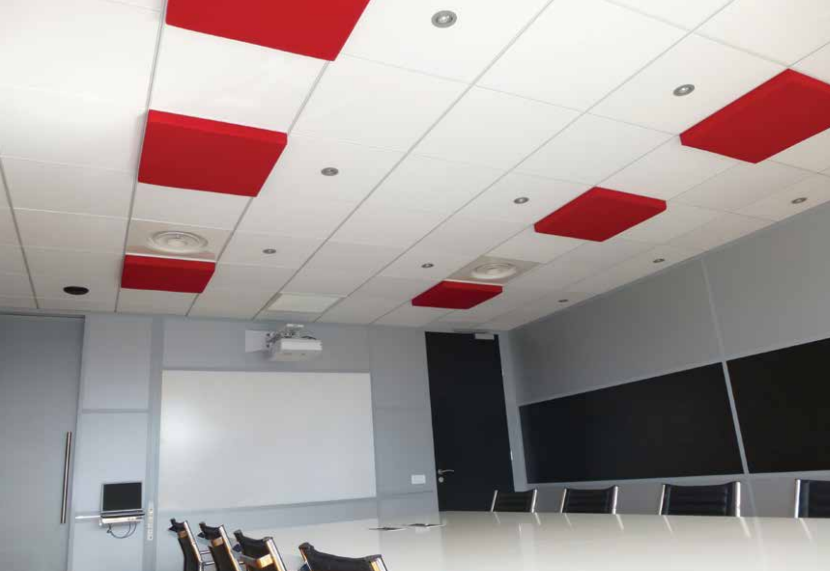
Pavés plafond acoustique UNI-color (collection SOUL) 60 x 60 cm fixés par système clip sur ossature
